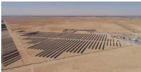
Nur Navoi Solar Power Project, Navoi District, Uzbekistan 乌兹别克斯坦纳沃伊地区努尔纳沃依太阳能发电项目
