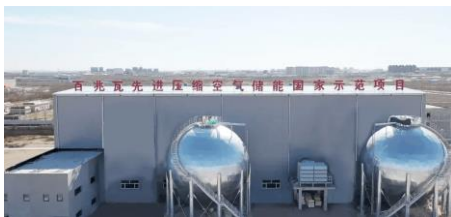
100MW压缩空气储能电站
